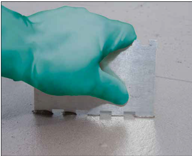
15 ... und erneutes Überprüfen der Nass-Schichtdicke von 1,3 mm.
