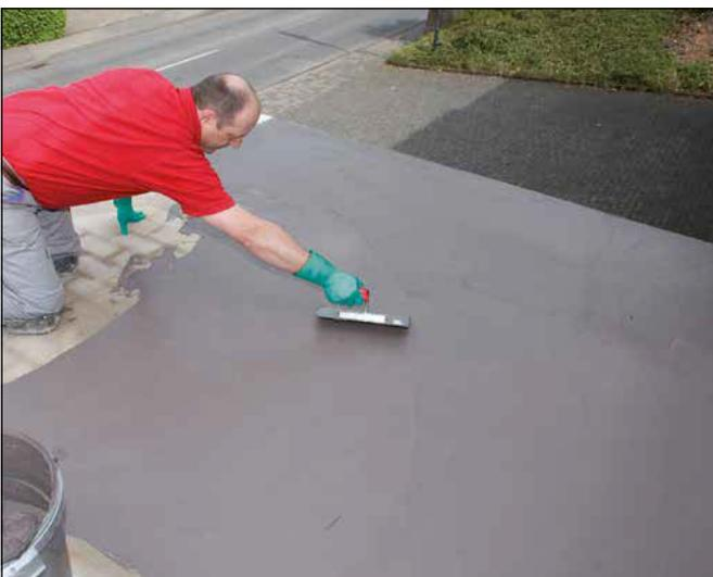
**11** Glätten der Sopro TurboDichtSchlämme 2-K mittels Glättkelle.
