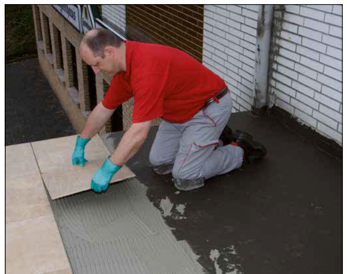
18 Einlegen und Einschieben der Platten in das frische Kleberbett.
