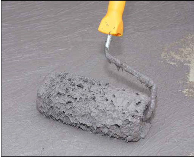
13 Die Verarbeitung der Sopro TurboDichtSchlämme 2-K kann auch mit einer Lammfellrolle erfolgen.
