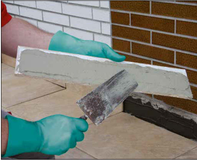
19 Auftragen eines Sopro Flexklebers (z.B. Sopro's No.1, Sopro FKM® XL) auf die Rückseite der zurechtgeschnittenen Sockelfliese ...
