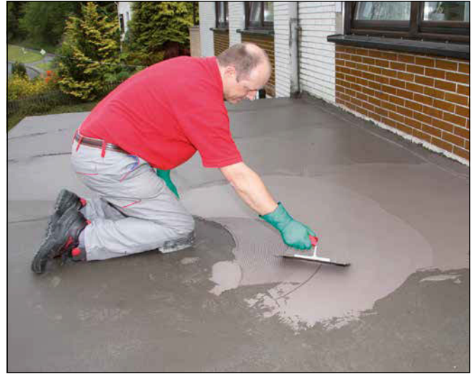
14 Aufbringen der 2. Schicht auf die schon nach 2 Stunden durchgetrocknete 1. Abdichtungsschicht ...
