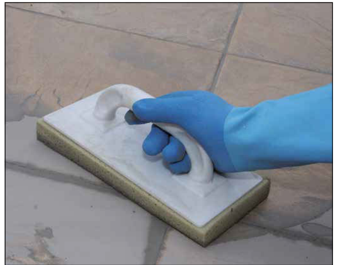
22 Abwaschen des Fliesenbelags nach ausreichender Standzeit der eingefügten Sopro Fugenmasse.
