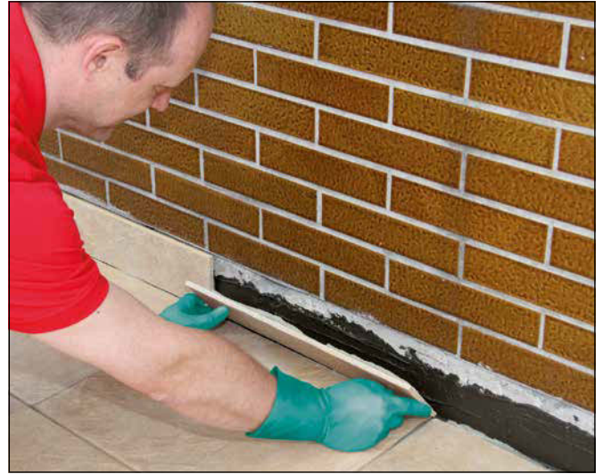
20 ... und Ansetzen der Sockelfliese.
