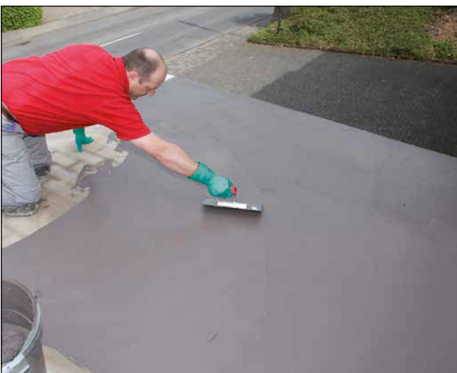
11 Glätten der Sopro TurboDichtSchlämme 2-K mittels Glättkelle.
